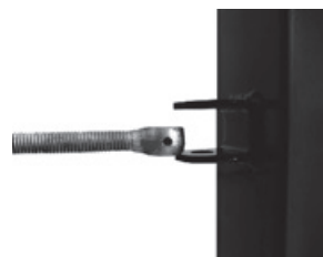
Откидной болт петли
